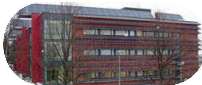
Vaisalan pääkonttori Helsingissä tuottaa noin 15 prosenttia vuotuisesta energian käytöstään itse tuottamallaan aurinkoenergialla. Yli 700 neliometriä aurinkopaneeleita verhoaa rakennuksen etelään päin olevaa seinää ja rakennuksen kattoa antaen 101 kilowatin huipputehon.
