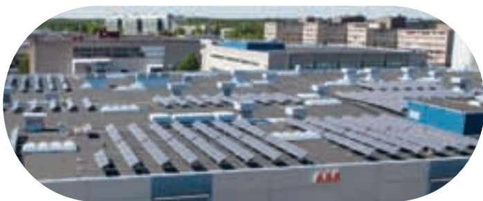
Aurinkosähköjärjestelmien vaihtosuuntaaja valmistavan ABB:n tehtaalla katolle asennettu 181 kilowatin aurinkosähkövoimala Helsingissä. Teholtaan voimala on Pohjoismaiden suurin valtakunnan sähköverkkoon kytketty aurinkosähköjärjestelmä.
